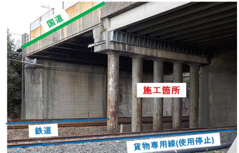
写真-1 現場状況
