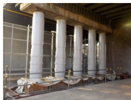
写真-3 耐震補強完了
