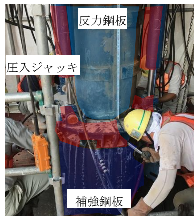
写真-2 補強鋼板圧入
