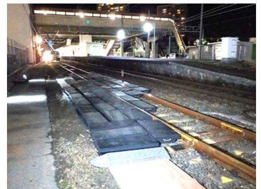
写真-3 ゴムマット敷設状態
