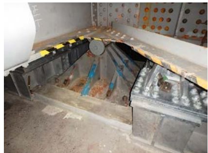
図-9 沓座修繕完了
