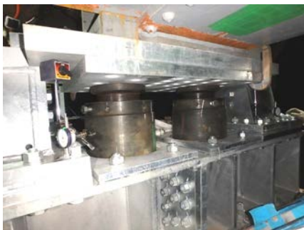
図-6 ジャッキ設置
