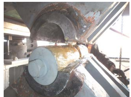
図-8 ピン交換 (新設)
