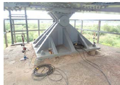
図-4 計測装置設置状況
