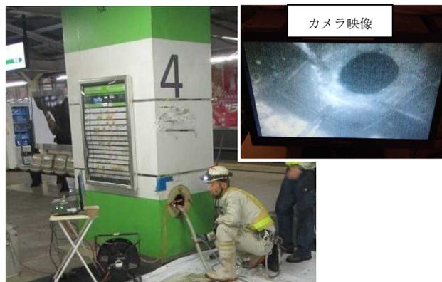
図-5 充填材打設状況
