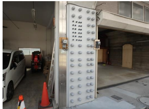
図-6 端列補強施工状況
