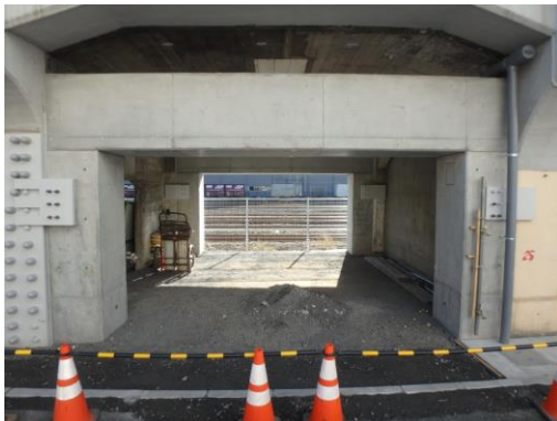
図-5 RCフレーム施工状況
