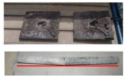
写真-3 ゴム沓等被害状況
