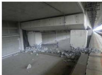
写真-1 支柱座掘状況
