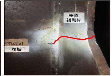
写真-2 き裂変状(タイプC)
