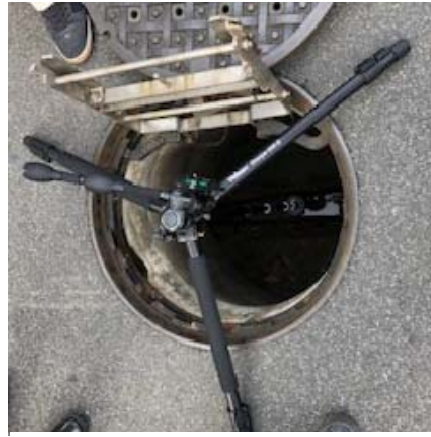
写真-2 設置状況
