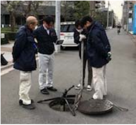
写真-1 設置状況
