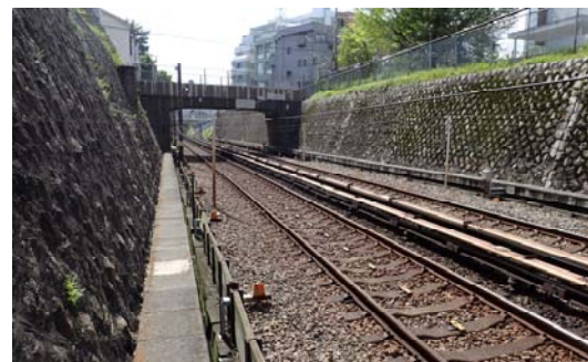
写真-1 施工前現場状況（線路側）
