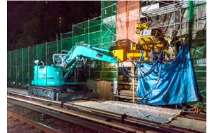
写真-3 地山の削孔状況
