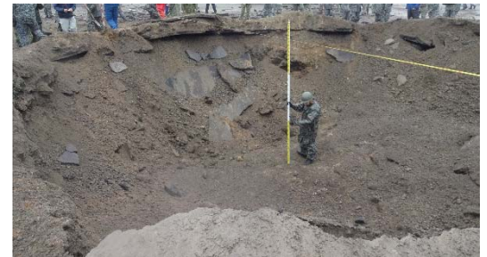
写真-1 現行の被害調査状況
