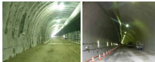
図2 トンネル内面(左:掘削・支保完了後、右:覆工コンクリート打設後)
