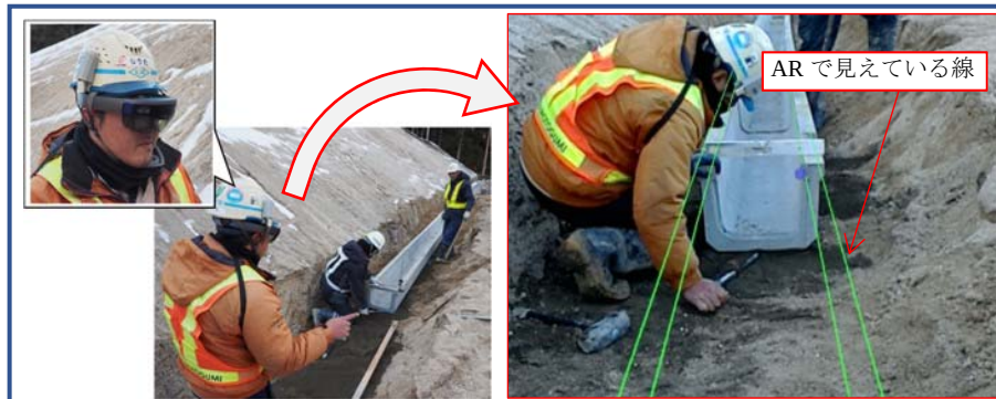
図 3 Hololens を使った据え付け状況
