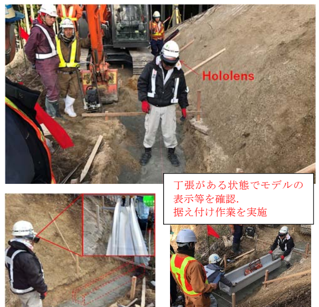
図2 Hololensを着用した試験施工状況
