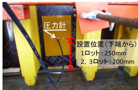
写真-1 圧力計の設置状況
