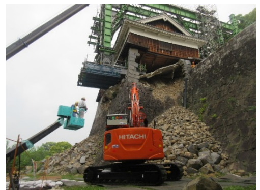
図4 無人化施工状況
