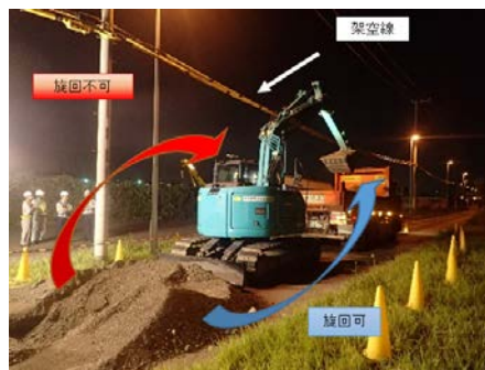
図-5 高圧線近接でのシステム使用状況
