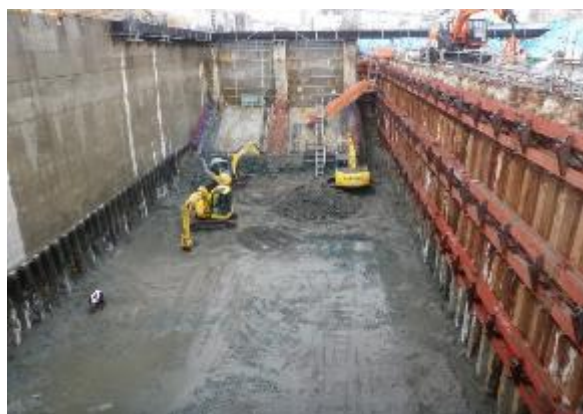
写真1 施工状況（最終掘削時）
