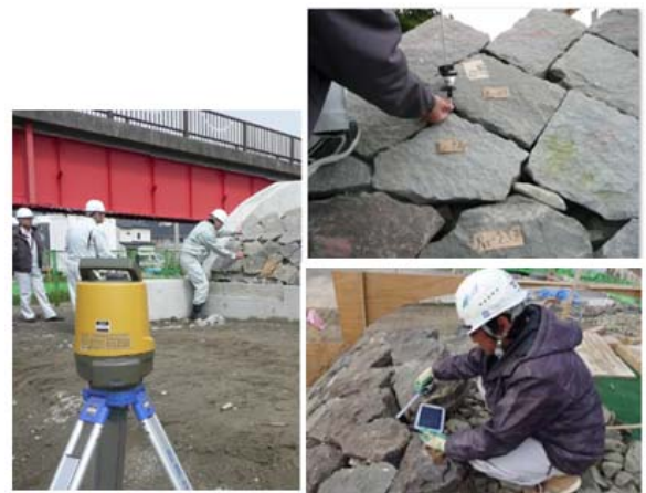
写真-3 石積み状況 (TS による座標誘導、タブレット確認)
