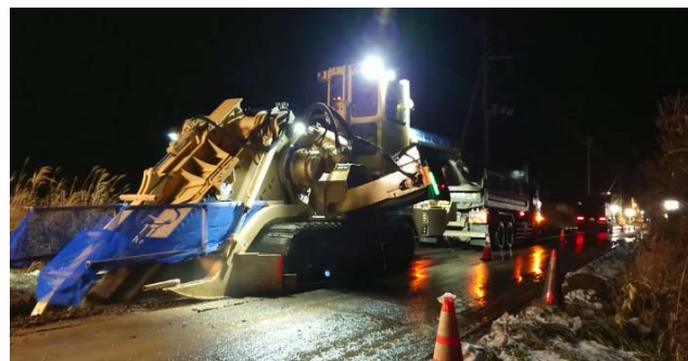
写真-4 施工状況
