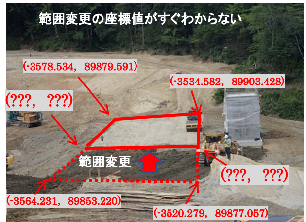
図-3 急な転圧範囲変更時の座標値例
