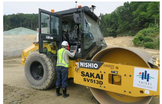
図-1 現場で転圧範囲を設定している状況
