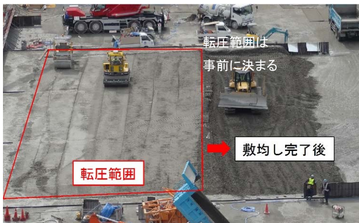
図-2 ダム工事における振動ローラ
