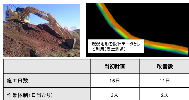
図-3 表土剥ぎ施工用設計データと活用結果
