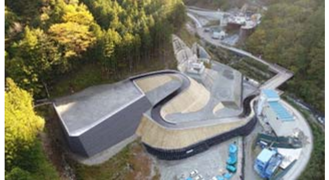
図-1 路体盛土全景
