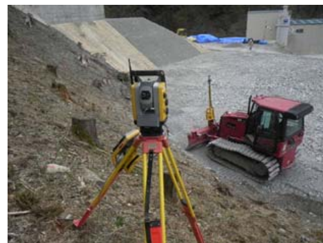
図-4 TS ブルドーザの敷均し状況
