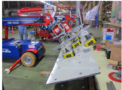
写真3 落下防止金具動作確認
