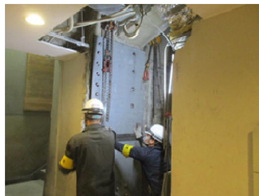
写真1 鋼板設置状況
