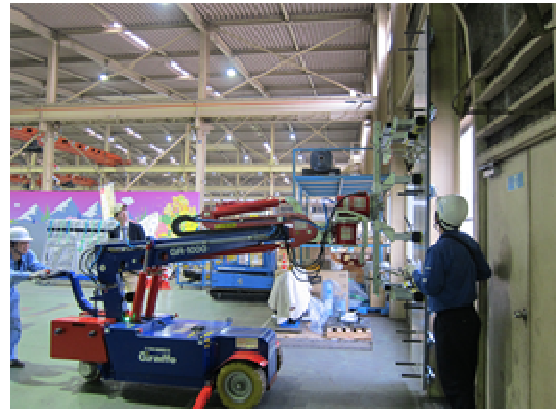
写真4 鋼板設置状況
