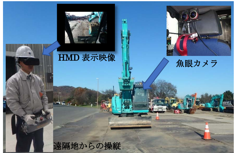
図1 臨場型遠隔映像システムを用いた無人化施工
