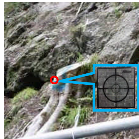
写真-2 標定点の設置(拡大)
