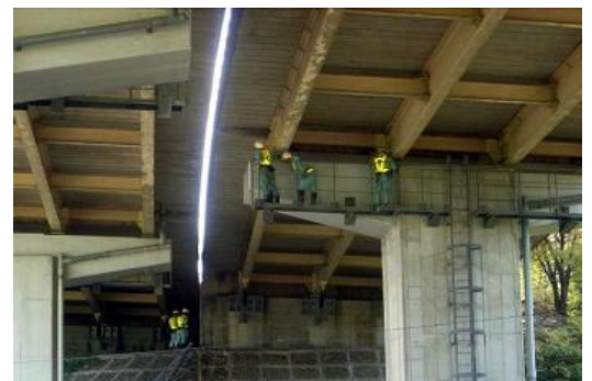
図1 橋梁の詳細点検
