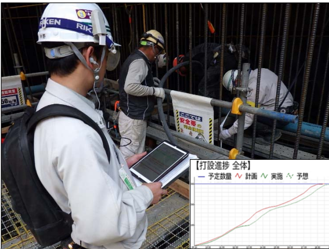
写真-2 地下打設箇所での T-CIM/Concrete 運用状況
