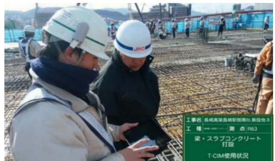
写真-1 打重ね時間管理システム運用状況
