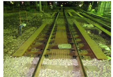
写真-1（仮工事桁架設完了）
