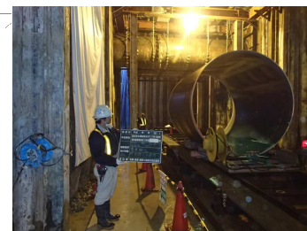
写真-4 配管運搬状況
