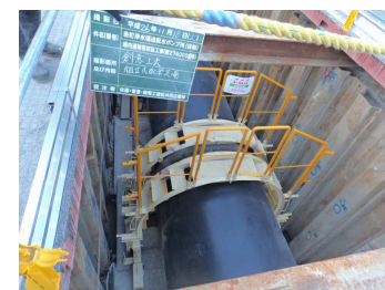
写真-5 移動式足場
