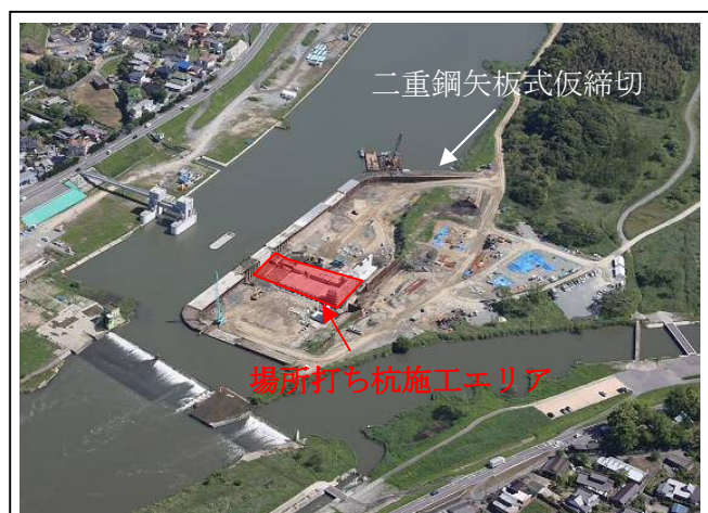
図－1 中間堰全体図（H28年4月撮影）
