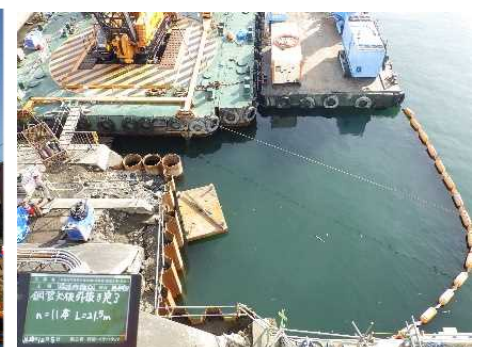
写真-7 引抜後全景
