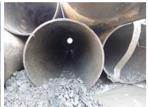
写真-3 先行掘り後鋼管内面
