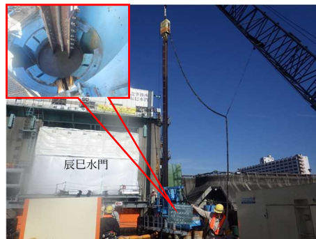
写真-2 先行掘り状況
