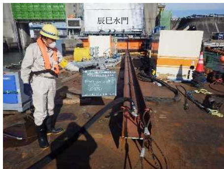
写真-1 ジェット管装着 H 型鋼
