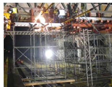
圖—5 線路內支保工
