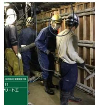
写真-2 壁部打設状況
