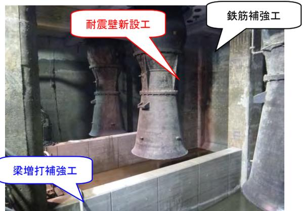
写真.5 ポンプ井施工完了状況
