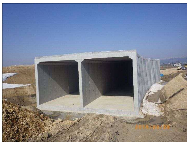
写真-4 設置完了全景
