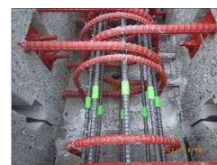
写真-3 頂版中央接続部の配筋状況 (ループ式継手)
