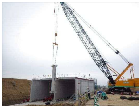
写真-2 部材組立状況(200t吊りクレーン使用)
