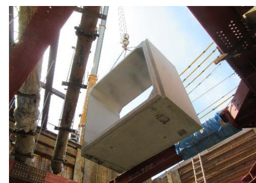
写真-4 揚重有効開口と新規カルバート
