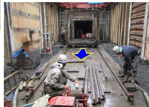
写真-3 既設カルバート横曳状況
