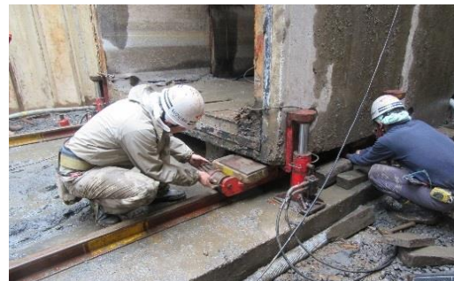
写真-2 爪ジャッキ・レール・台車
