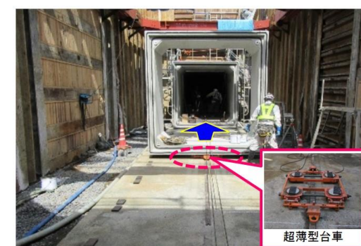
写真-5 超薄型台車での搬送状況
