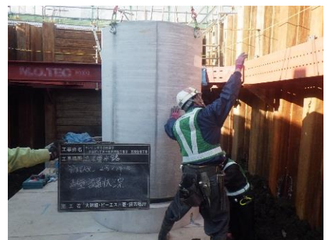
写真-3 管理人孔新設
