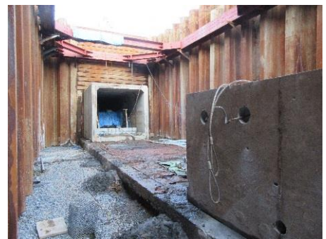
写真-2 下半部撤去（分水停止中）
