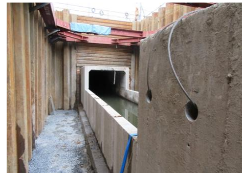
写真-1 上半部撤去（分水停止前）
