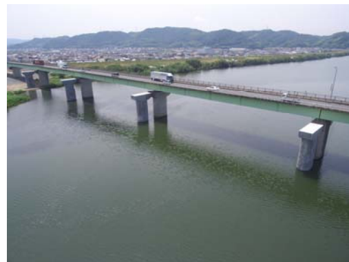
写真－１ 完成写真
