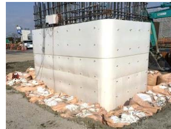
写真-3 湿潤・保温養生マット
