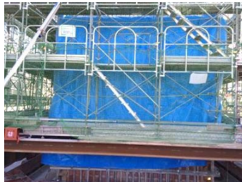
写真-2 断熱養生シート
