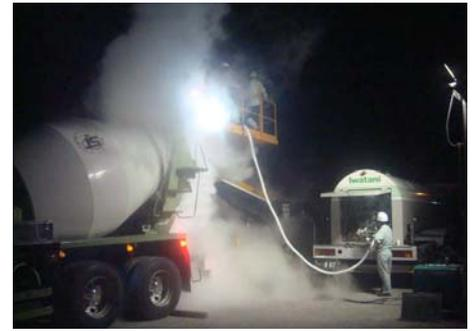
写真1 液体窒素冷却状況
