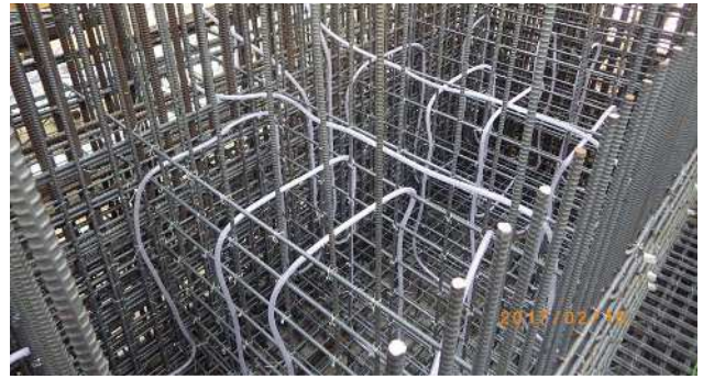
図4 パイプクーリング設置状況
