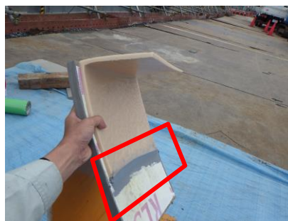
図3. ピースと不織布の防水塗膜の接続部
