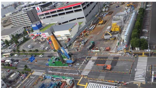
写真1 都道部地中連続壁施工状況
