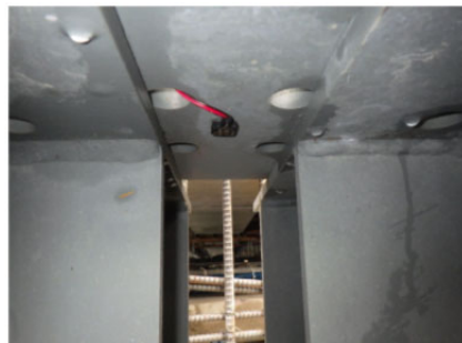
写真-3 センサー設置(支承3)
