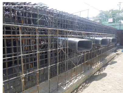
写真-2 隅角部配筋状況
