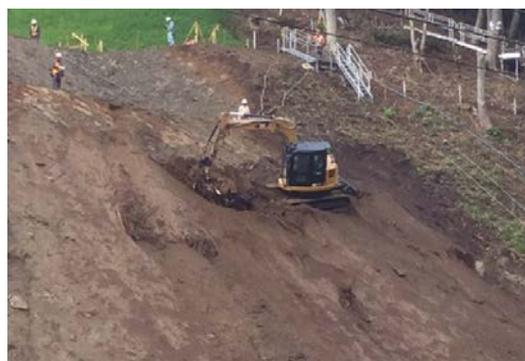
図-3 クライミングバックホウによる掘削
