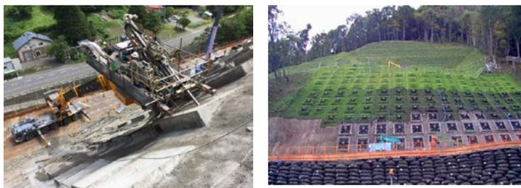
図-5 スカイステーションによるグラウンドアンカー工
