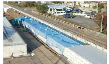
写真-1 養生ネット飛散防止対策
