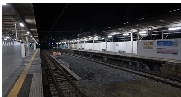
写真4 工事桁撤去完了・軌道復旧写真
