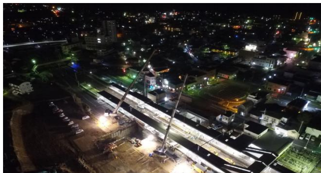
写真3 工事桁相吊り状況（上り線）
