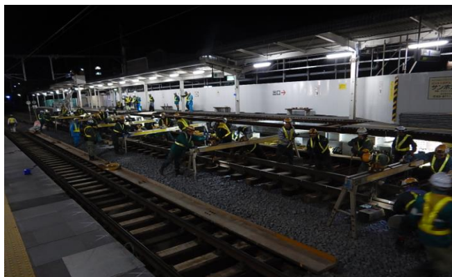
写真2 軌きょうの撤去状況（上り線）
