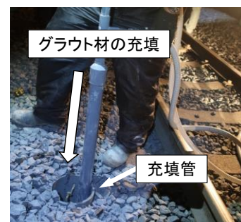
図7 グラウト充填状況
