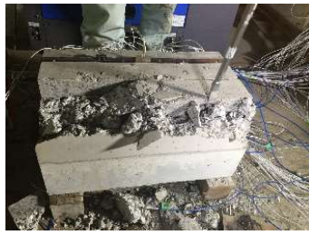
写真-4 加熱後の破砕状況
