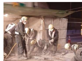
写真-1 後打ちコンクリートの研り作業
