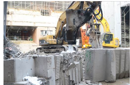
図-4 現場実証実験状況
